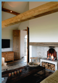
De eiken balken van de oorspronkelijke boerderij dragen het dakgebinte.
